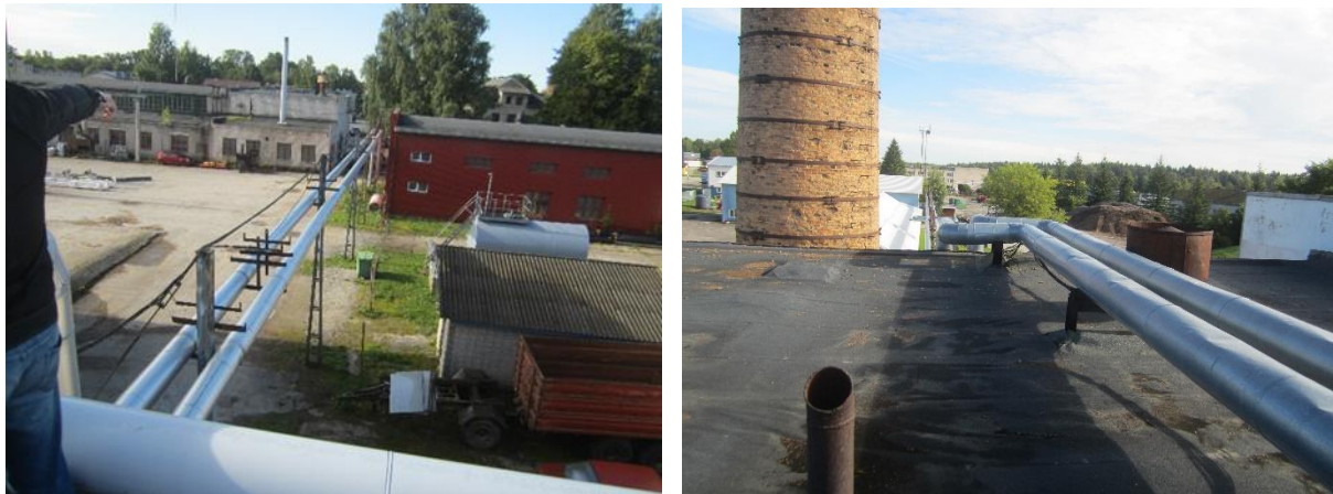
Joonis 2.9. Tehnika kaugküttevõrgu maapealse torustiku lõigud
