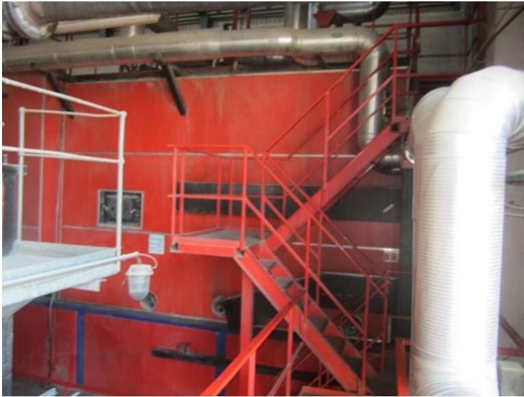
Joonis 2.1. Hakkpuidukatel GVB-11 (Vølund Danstoker 4 MW)
