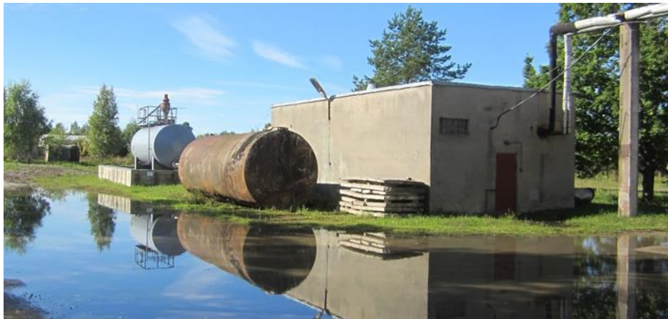
Joonis 2.84. Vabriku katlamaja põlevkiviõli mahuti
