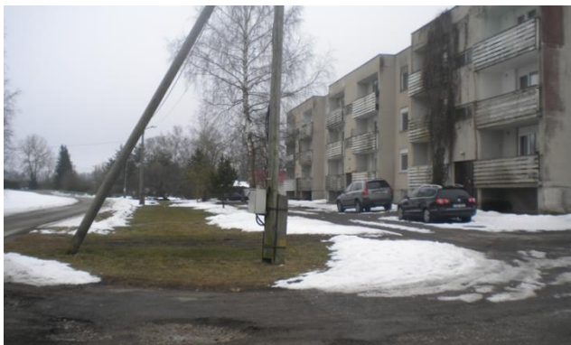
Joonis 3.6 Soojatrass Kuuse tee 5 ees
