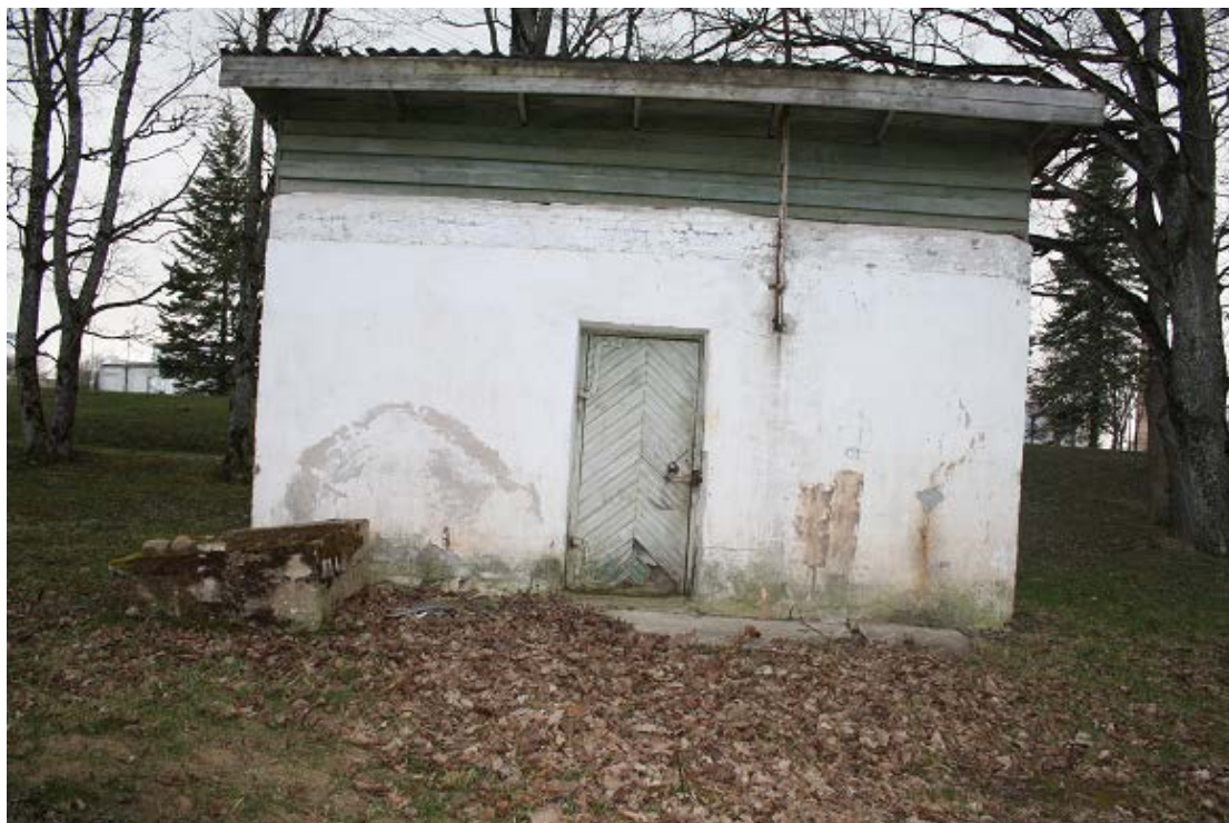
Joonis 4. Torma Pargi puurkaevpumpla välisvaade
