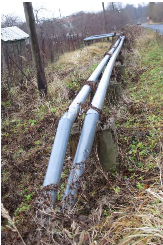
Joonis 3.1. Maapealne kaugküttevõrgu torustik Pika tänava ääres
