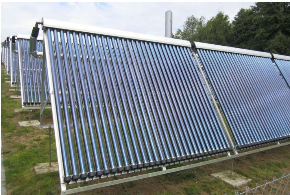
Joonis 6.3. Päikesepaneelid sooja vee tootmiseks
