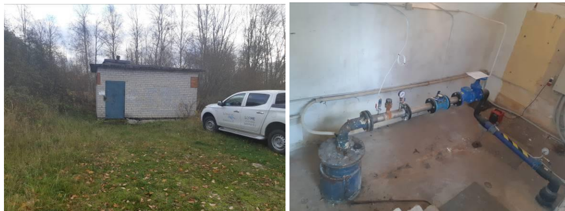
Joonis 6.4 Kraavi tn 2A puurkaev-pumpla
