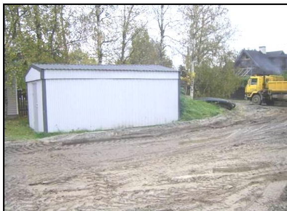
Joonis 6.11 Paelrohu puurkaev-pumpla
