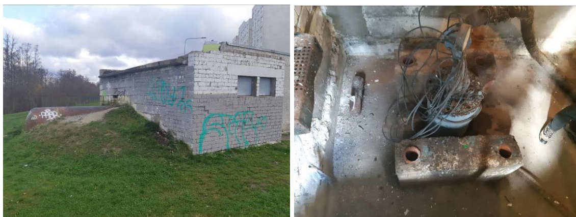
Joonis 6.6 Veeru tn 9A puurkaev-pumpla
