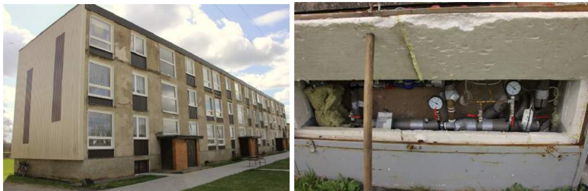
Joonis 4.4 Helme alevi kaugküttetarbija (Karja 2) ja selle soojussõlm
