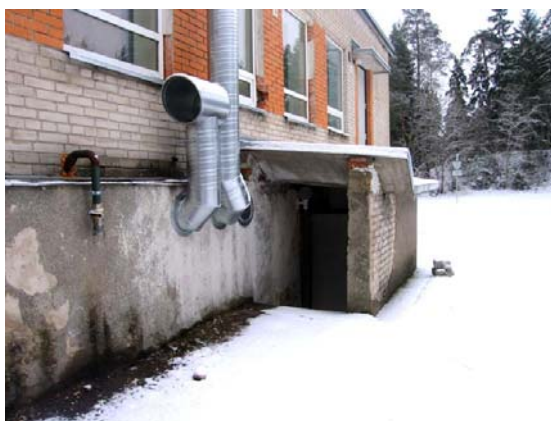
Pilt 2 -Sisepääs katlaruumi
