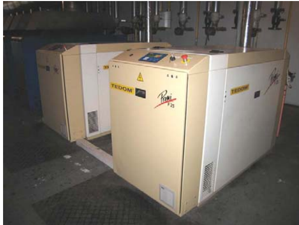
Pilt 1 -Firma TEDOM gaasimootorid
