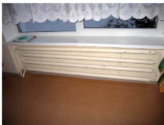
Pilt 9 -Toruradiaator.
