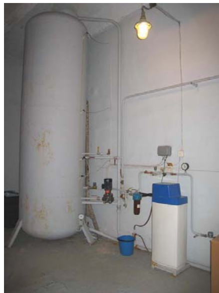
Pilt 10 -Veepehmenusseade ja lisaveemahuti
