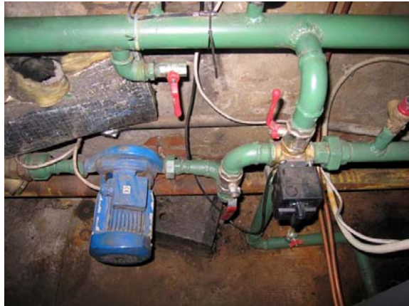
Pilt 5 -Tsirkulatsioonipump
