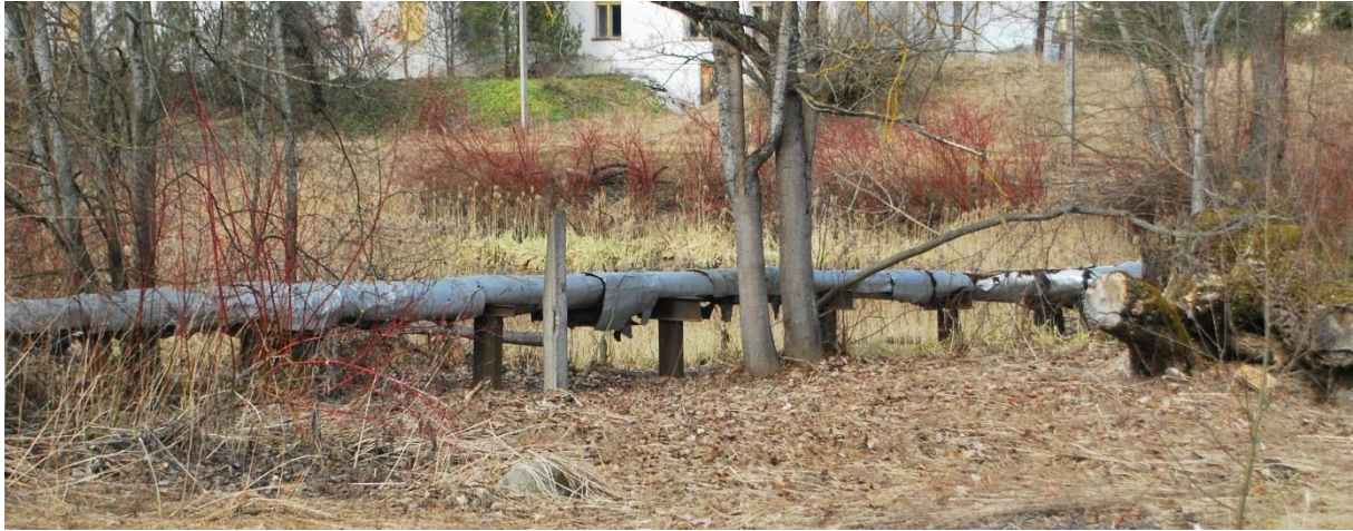
Joonis 7.9 Kasutusest väljas väga halvas seisus maapealne kaugküttetoru
