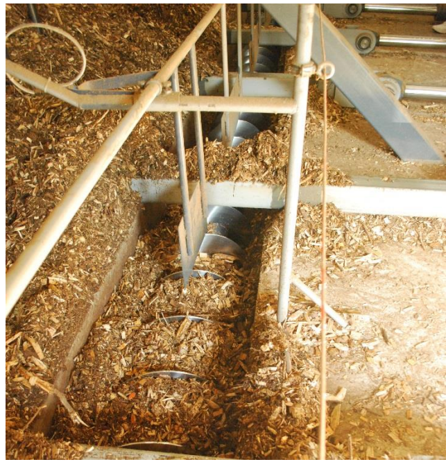
b) Täisautomaatse hakkelao tigu ja hüdropump
