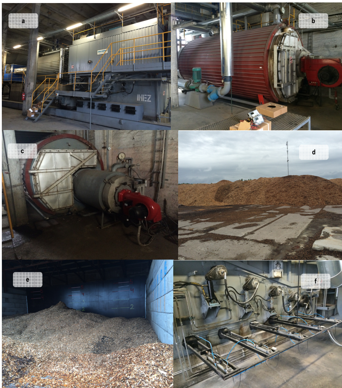
Joonis 3.1.1 – a). Witermo 8 hakkepuidukatel, b). Tubox põlevkiviõlikatel, c). K-80 põlevkiviõlikatel, d). Kütuse ladustamisplats, e). Liikuva põrandaga kütuseladu, f). Tuhaärstussüsteem
