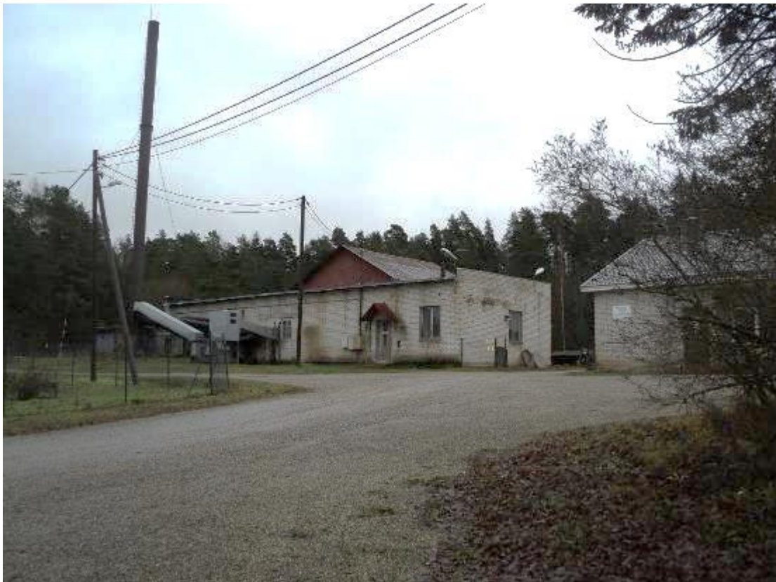
Joonis 2 . Vaade katlamajale
