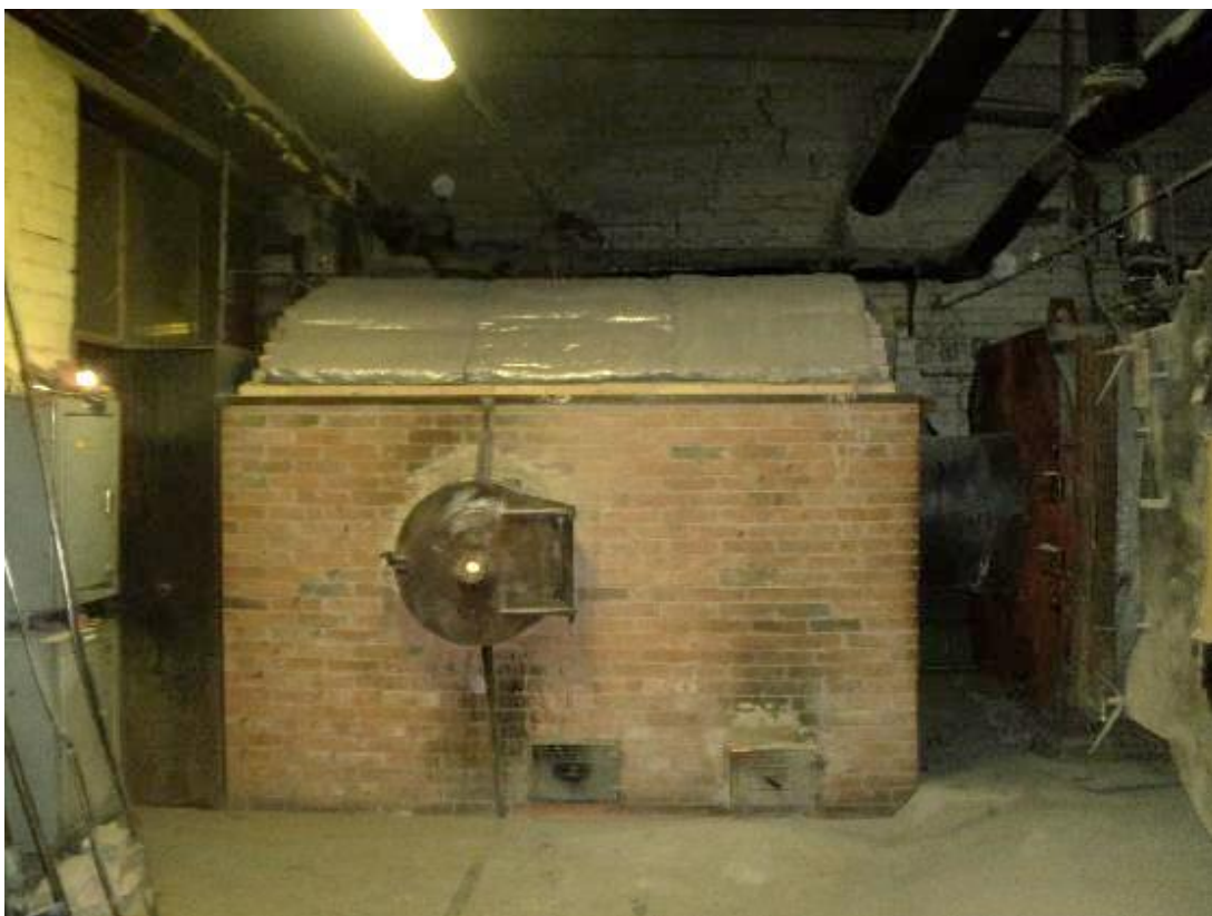
Joonis 4 . Katel töötab kohalikul kütusel alates 1994. aastast eelkoldega
