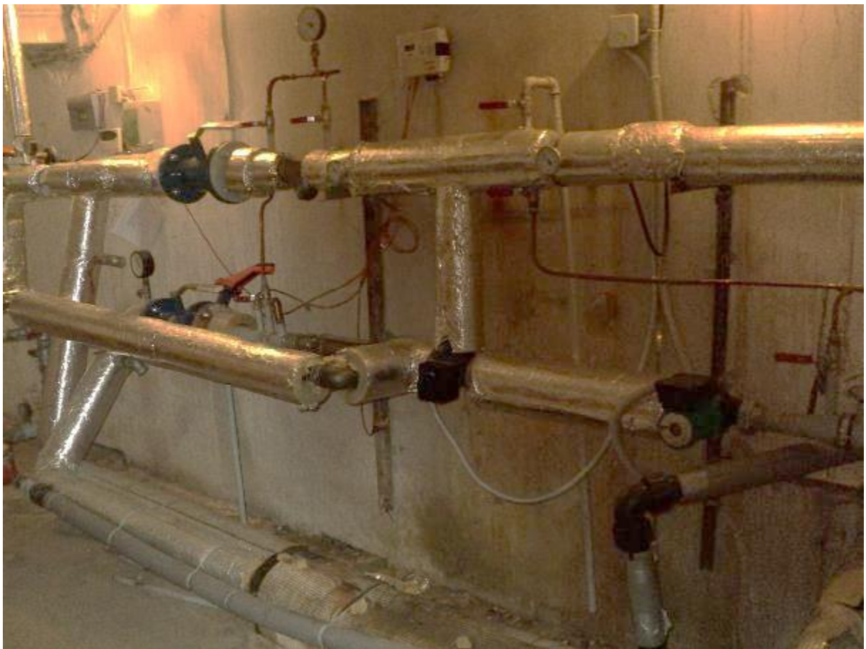
Joonis 6. Vaade enamlevinud soojussõlmele Kambjas
