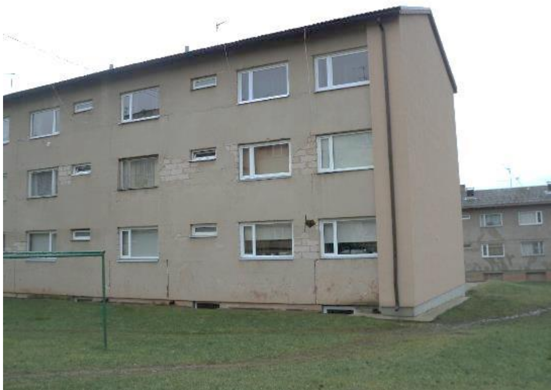
Joonis 12. Sellel elamul on otsaseinad soojustatud
