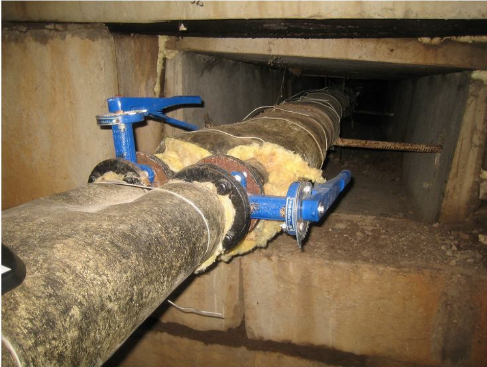
Joonis 4.10. Isoleeritud kaugküttetorustik – II KP, kaev 36 [20]
