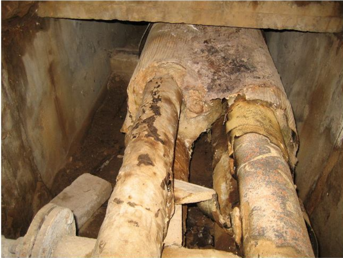
Joonis 4.8. Amortiseerunud kaugkütte ning sooja vee torustikud - kaev K25 [20]
