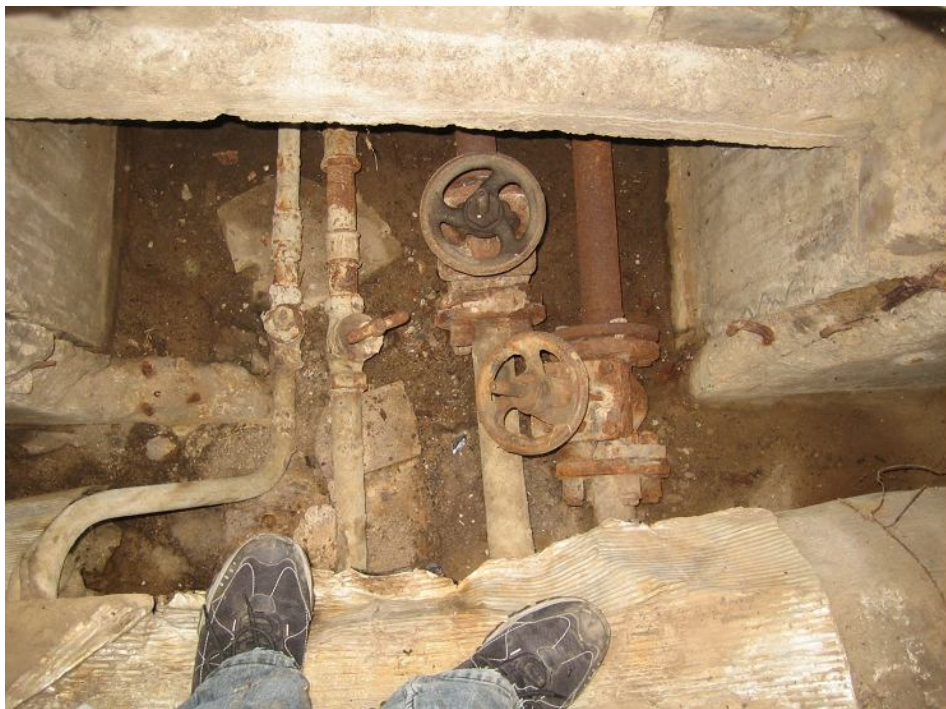
Joonis 4.11. Praktiliselt isoleerimata sooja vee jaotustorustik , kaev 24 [20]
