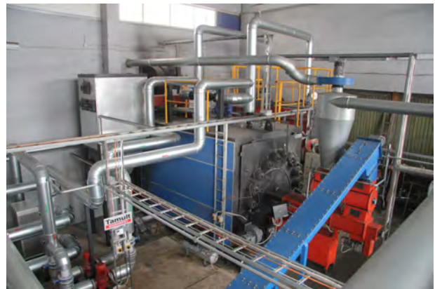
Joonis 2.4 Vaade biokütusekatlale ja kütuse etteande süsteemile (foto Ü. Kask)
