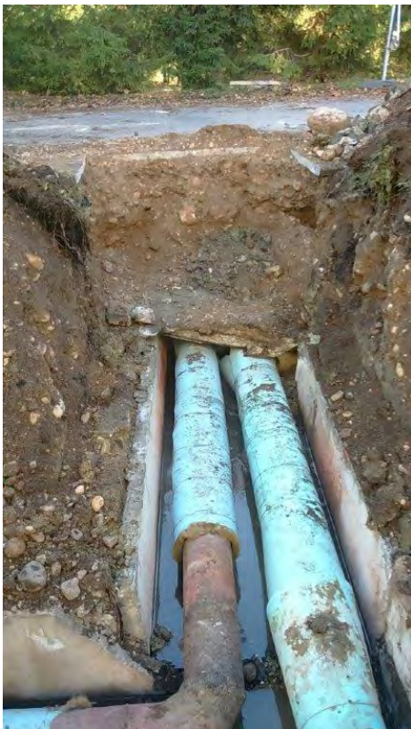
Joonis 9.5 Ristiku 1 elamu ees Ristiku ja Pioneeri tn ristmiku lähedal 2015.a oktoobris toimunud kaugküttevõrgu avariikoha pildid (Tõnu Viherpuu fotod)
