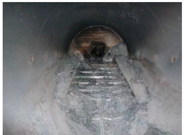
Joonis 2.6 Biokütusekatla kolde sisevaade (foto Ü. Kask)
