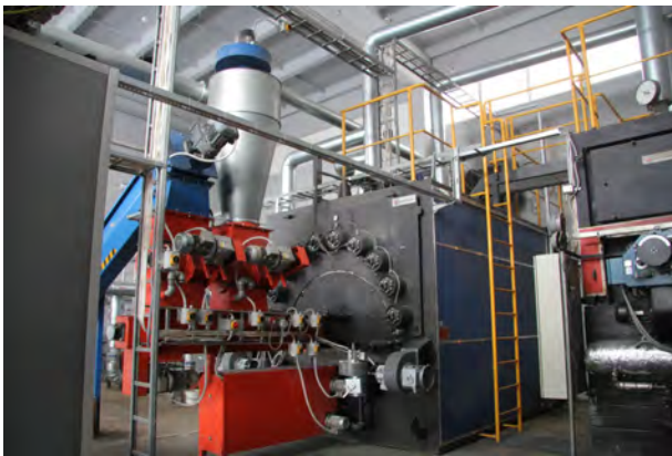
Joonis 2.3 Lihula katlamaja biomassil töötav katel ja paremal õlikütteil töötav reservkatel (foto Ü. Kask)
