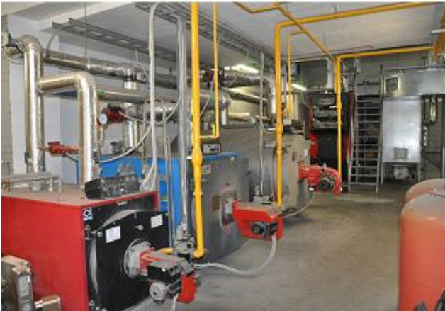
Tabivere katlamaja: gaasikatlad ja hakkepuidukatelseadmed
