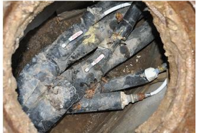
Tabivere korterelamute soojussõlmi; kaugküttetorustiku sisend ja kaev
