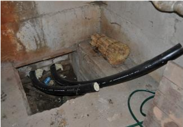
Tabivere korterelamute soojussõlmi; kaugküttetorustiku sisend ja kaev
