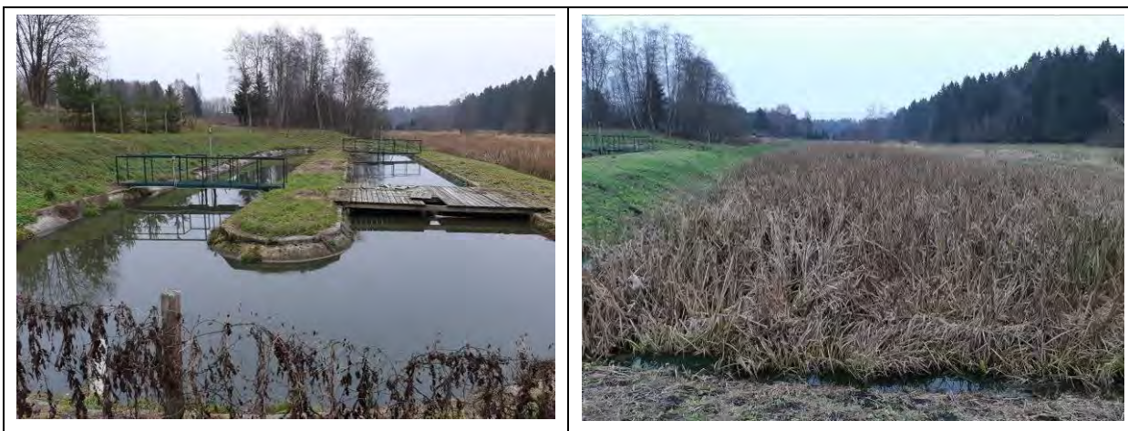
Joonis 11. Tsooru küla reoveepuhasti. Fotod: OÜ Alkranel 07.11.2018.
