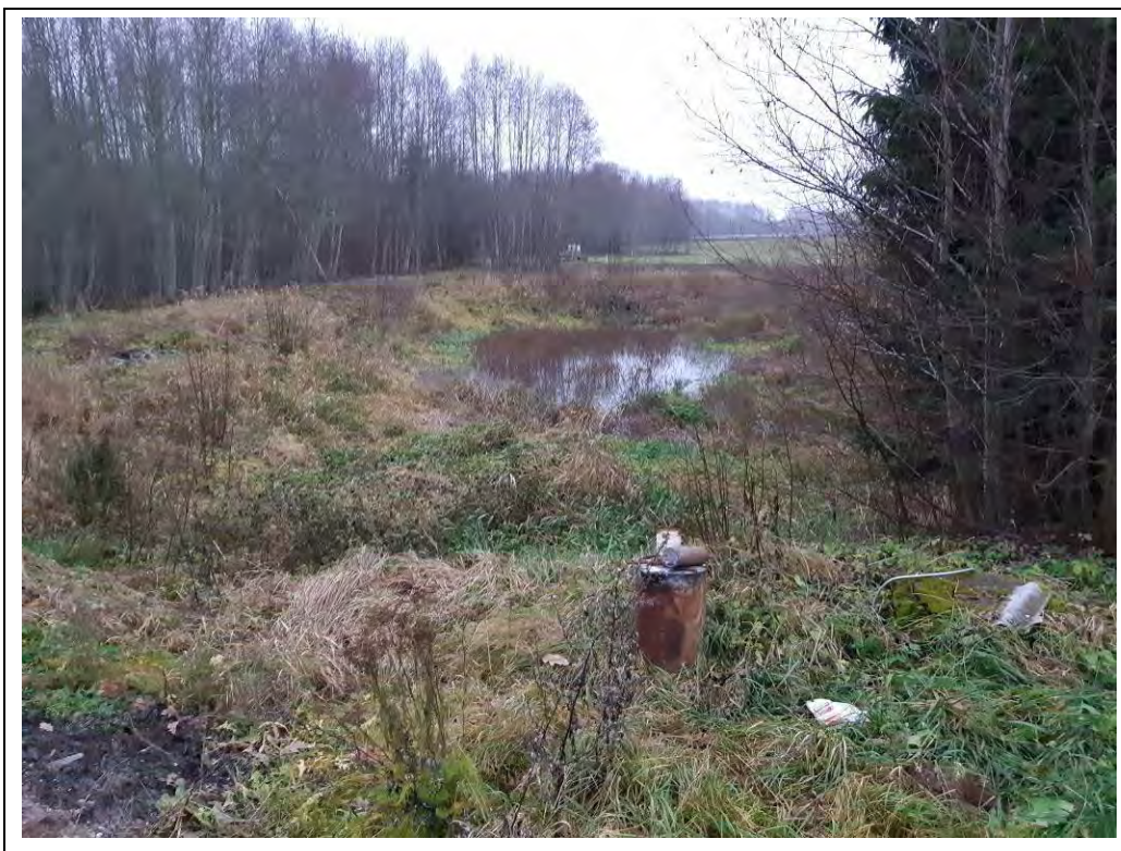
Joonis 21. Visela küla reoveepuhasti. Fotod: OÜ Alkranel 07.11.2018.
