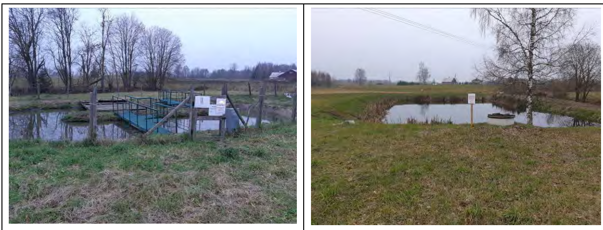
Joonis 13. Kraavi küla reoveepuhasti. Fotod: OÜ Alkranel 07.11.2018.
