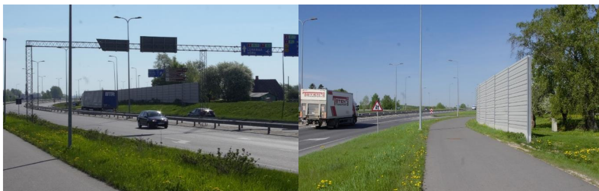
Müratõkked Tartu läänepoolse ümbersõidu ääres (Variku viadukti ja Postimaja liiklussõlme vahel)
